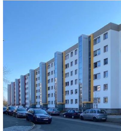
Abb.: sanierte Wohnzeile mit barrierefreier Erschließung durch Aufzüge Elsterwerdaer Str.
