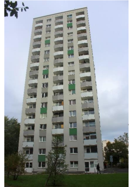
Abb.: saniertes Hochhaus Prohliser Allee (Quelle: QM 10/2021)
