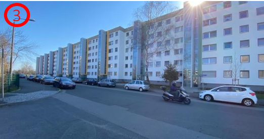
sanierte Zeilenbebauung Elsterwerdaer Str.
