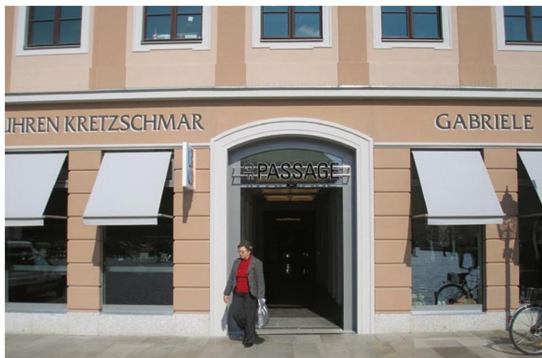
Dieses Beispiel zeigt eine gelungene Fassadenbeschriftung.
