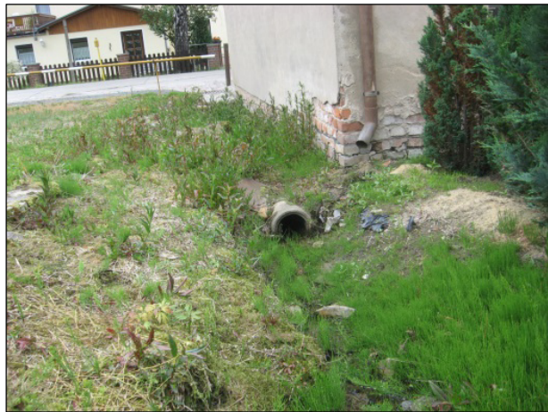
Bild 4: Vor der Maßnahme: Wilder Weiher Graben, Einlauf in Verrohrung
