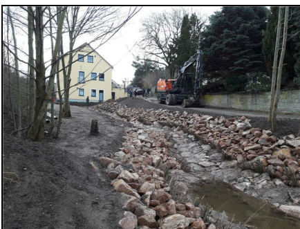
Abb. 1: Setzpackrampe mit Tosbecken, 12.03.2019
