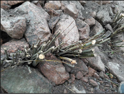
Abb. 2: Begrünte Steinschüttung mit Heckenbuschlage, 12.03.2019
