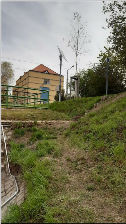
Abb. 2: Digitaler Wasserstandsmesspegel (hier Solarpaneel, Kamera, Datenlogger) BUW003 im HRB Kaitzbach 1 Hugo-Bürkner-Park, 15.04.2020
