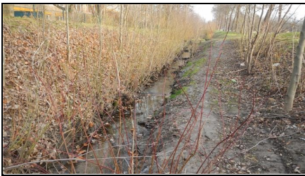
Abb. 4: Nach der Maßnahme: Einbau von Buhnen zur Strömungslenkung, 09.01.2018
