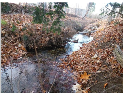
Abb. 5: Nach der Maßnahme: Fischunterstand aus Wurzelstubben mit Kiesbank, 16.12.2020
