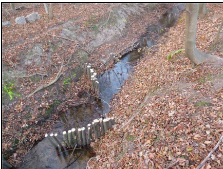
Abb. 4: Nach der Maßnahme: Rechenbühnen zur Initiierung von Profilvarianz, 16.12.2020
