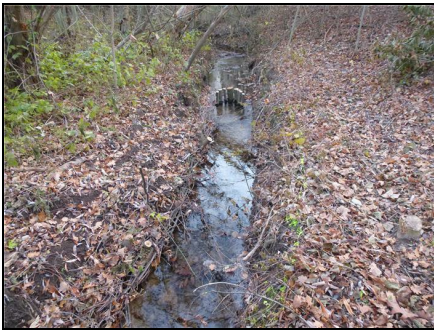
Abb. 3: Nach der Maßnahme: abschnittsweise Einengung des Gewässerquerschnitts durch Bühnen und hinterpflanzte Toffaschinen, 16.12.2020
