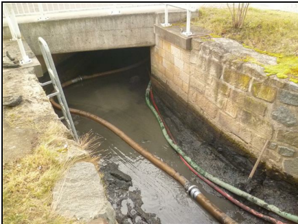
Abb. 4: Während der Maßnahme: Sedimentberäumung mittels Saugbagger, 30.01.2020
