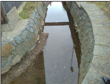
Abb. 5: Nach der Maßnahme: stromab des beräumten Gewässerabschnitts, 19.02.2020
