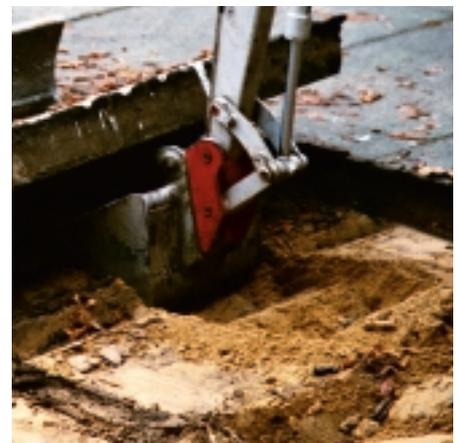
Abb. 2.1: Versickerungsanlage im Bau
